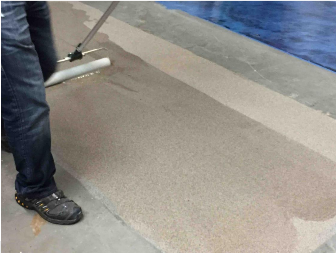
Foto: Aanbrengen primer.
