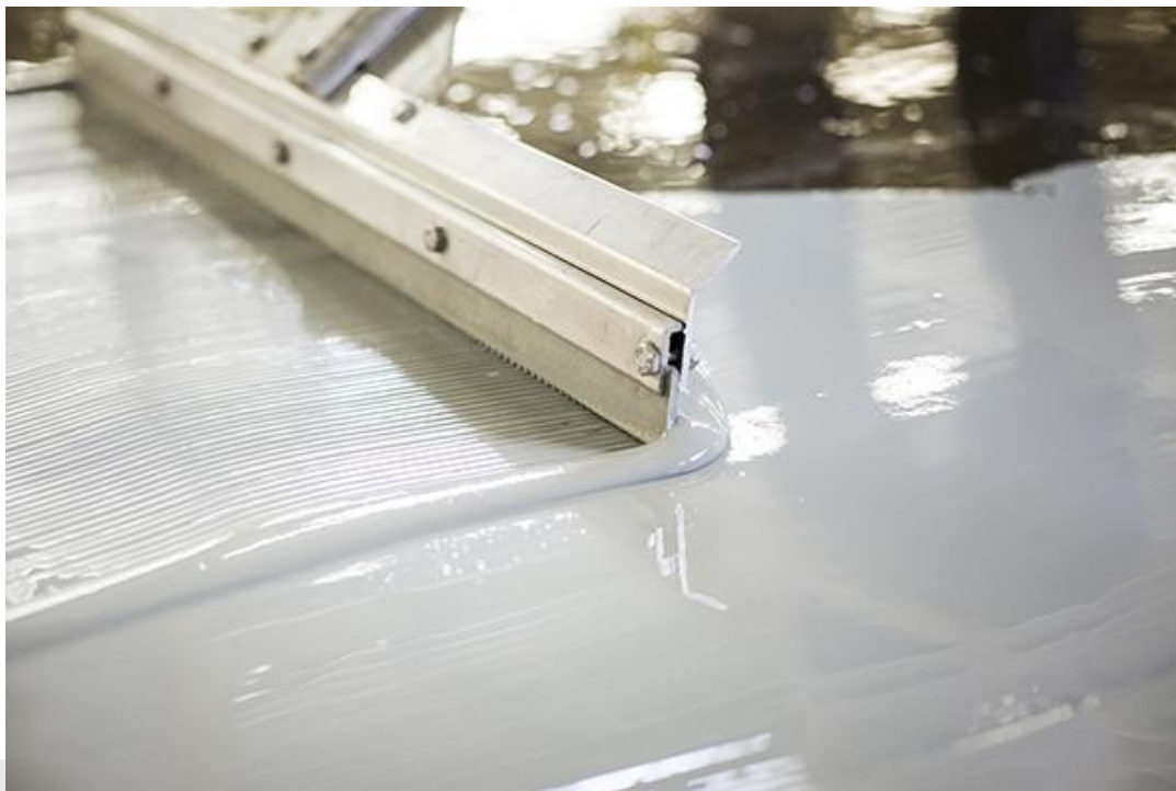
Foto: Aanbrengen vloeistofdichte bescherm laag.
